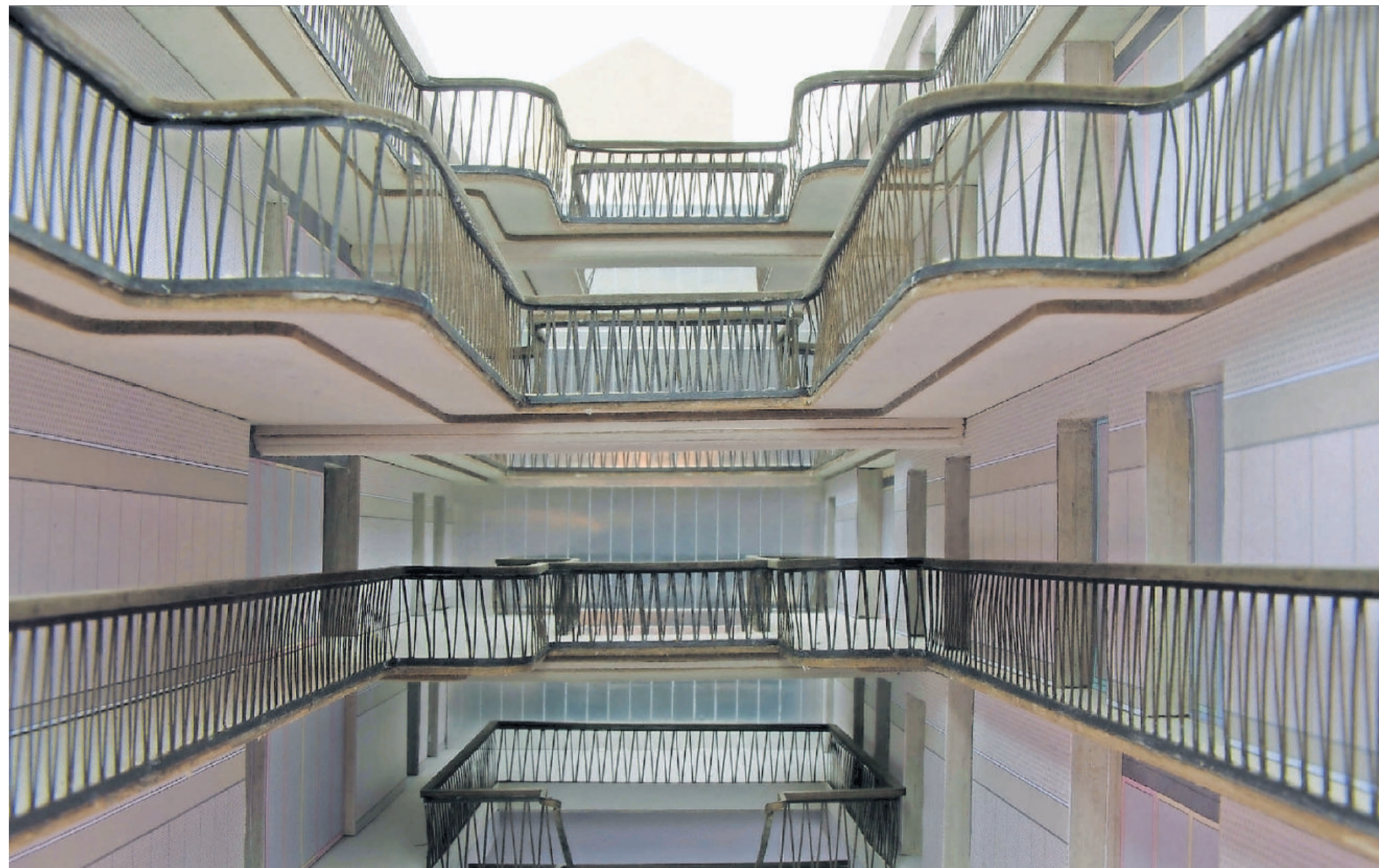
Die Wohnungen des Studentenhauses auf der Erlenmatt sind über einen Innenhof und Galerien zugänglich. Das ergibt einen spannenden, halböffentlichen Raum.
